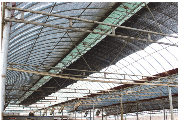
〈그림 2〉 복사열 차단을 위하여 지붕에 차광막 설치
