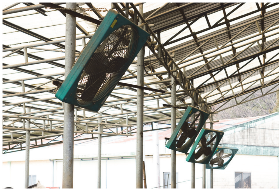
〈그림 3〉 최적의 환기 개선을 위한 올바른 선풍기 설치
