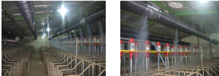
<그림 2> 돈사내부 환기를 위한 덕트 설치
