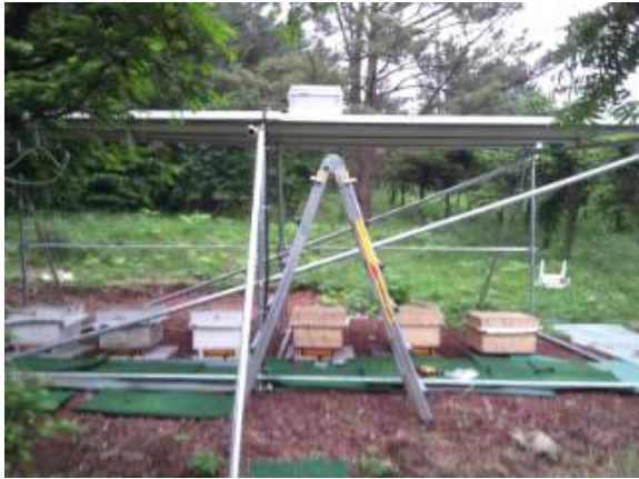
그림 32 태양광 모듈 설치 모습 (외부보호함 덮개에 설치)
