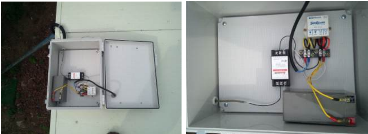
그림 31 설치된 외부 보호함 내부 모습(충전컨트롤러/배터리/써지보호기)
