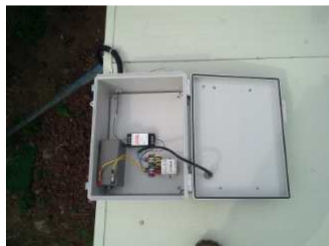
그림 56 외부보호함 설치
